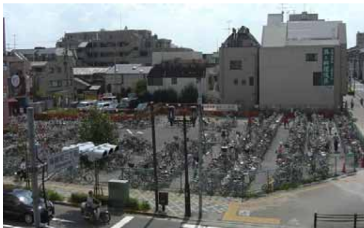
&lt; 61 街区の現況写真（北側より） &gt;
