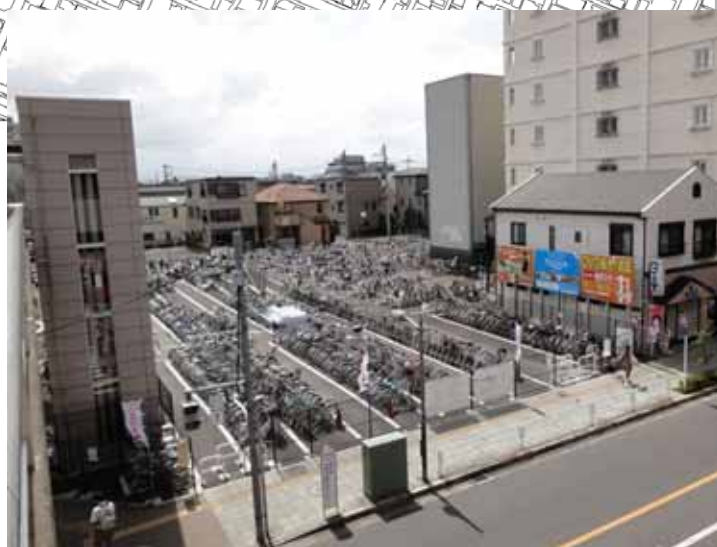
< 58 街区の現況写真(北側より) >
