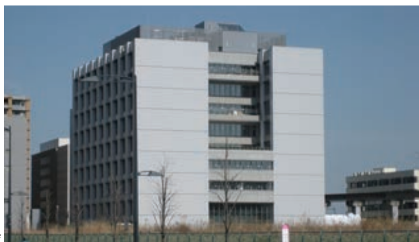
立川第二法務総合庁舎
