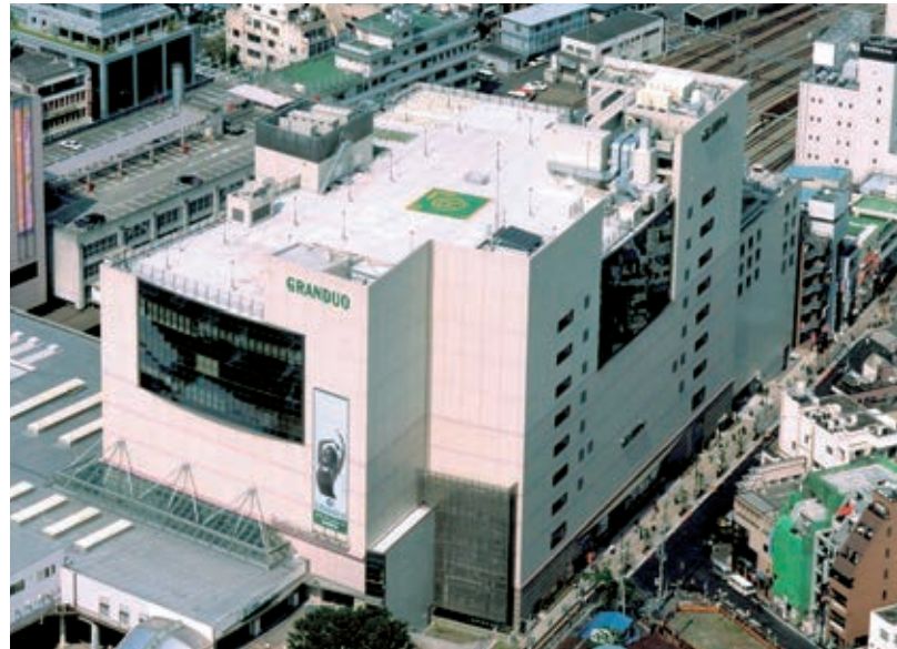
立川駅南口合体ビル
