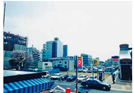
アレアレア着工前の モノレール立川南駅東側
