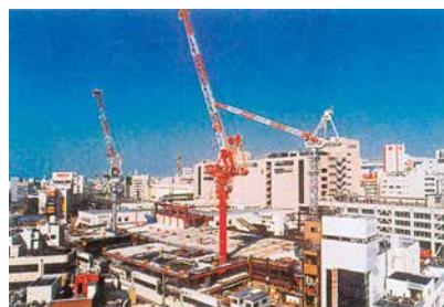
建設中の合体ビル
