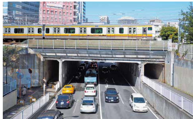
立川立体完成後 平成29(2017)年11月
