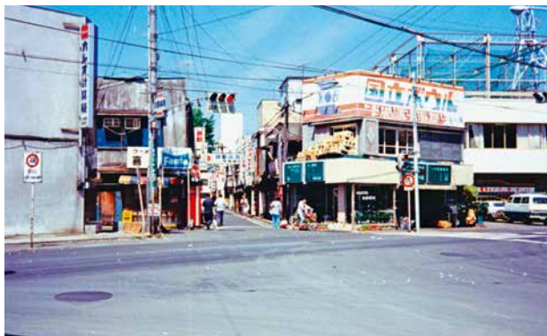
昭和52(1977)年 立川立体完成前
