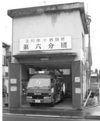
早急な建てかえが望まれる
