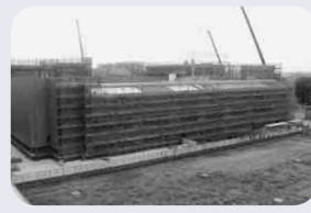
建設が進んでいます
