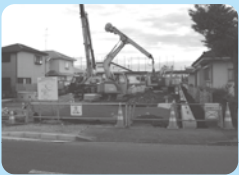
駐輪場を造成中 (西武立川駅)
