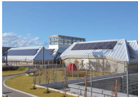
市役所屋上の太陽光パネル
