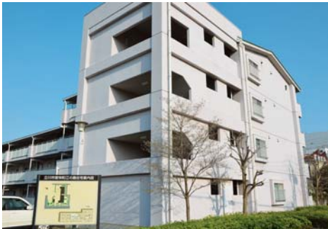
市営栄町江の島住宅
