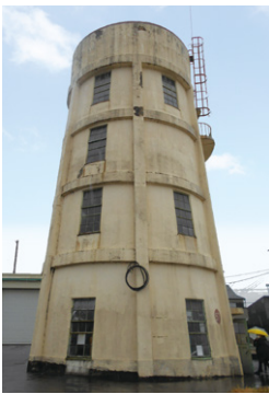
高松駅近くに残る給水塔
