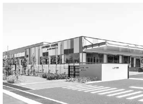
東調理場 外観（令和5年度開業）
