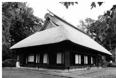
川越道緑地古民家園内「小林家住宅」
