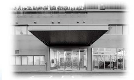
管理棟 正面入り口
