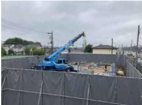
1階床スラブ解体工事の様子
