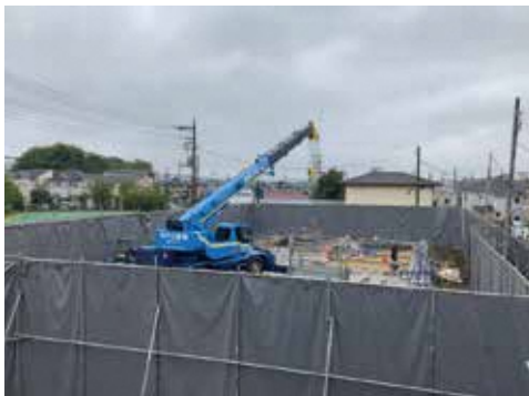
1階床スラブ解体工事の様子
