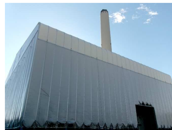
工場棟の全覆い仮設テントの外観
