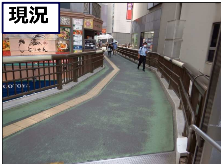
舗装の摩耗・ひび割れがみられる
