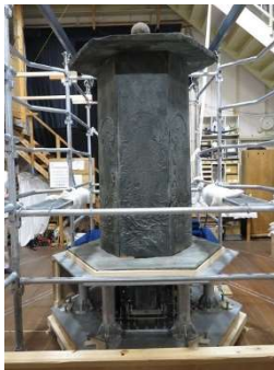
修理工房組上点検
