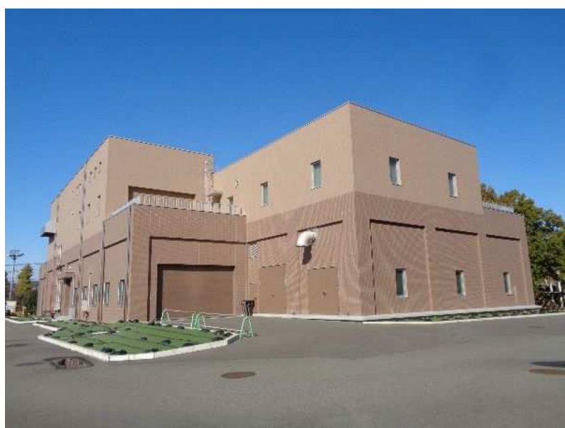
図 2-4 錦町ポンプ場（下水送水施設）
