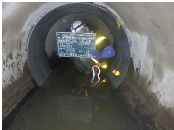
図 4-25 不明水対策（管きよ補修工事）の施工例
