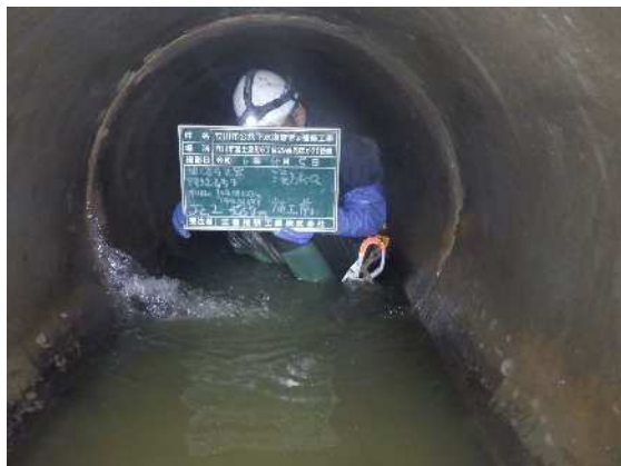
図 4-25 不明水対策（管きよ補修工事）の施工例
