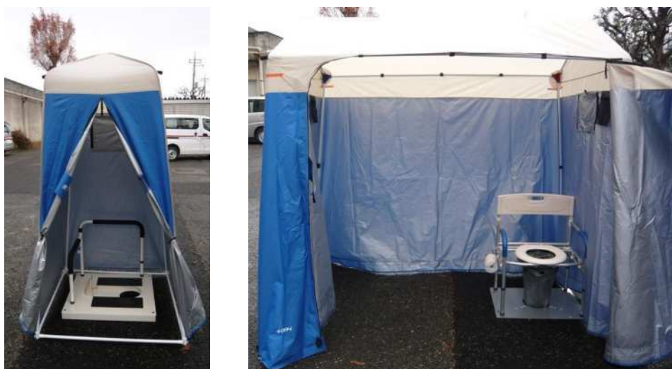
図 4-17 マンホールトイレ
