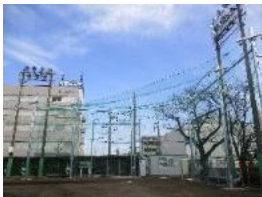
改修した泉町野球場ネットフェンス
