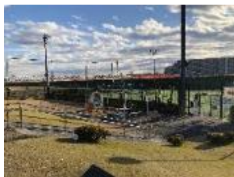
LED 化を検討している屋外スポーツ施設
