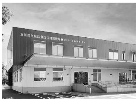
西調理場 外観（平成25年度開業）
