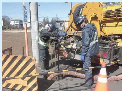
清掃 特殊車両で洗浄して土砂を吸い取ります
