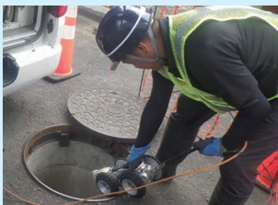
点検・調査 カメラを管の中に入れて確認します
