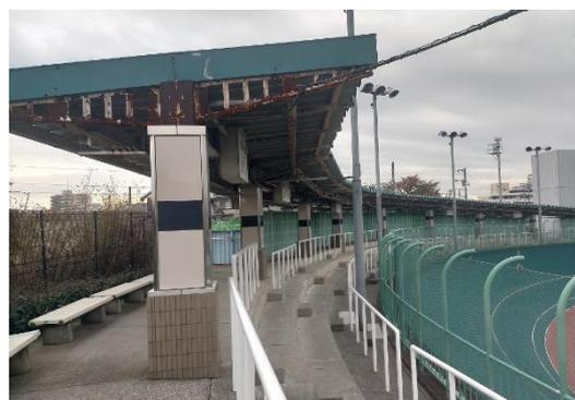
写真 老朽化した競輪場施設・設備の様子
