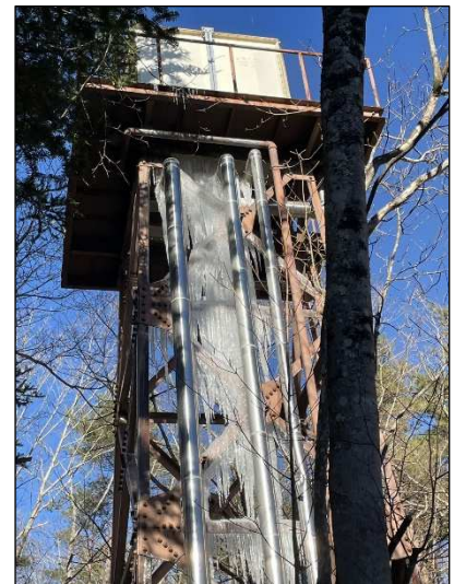
高架水槽の漏水 (令和 7 年度発生)
