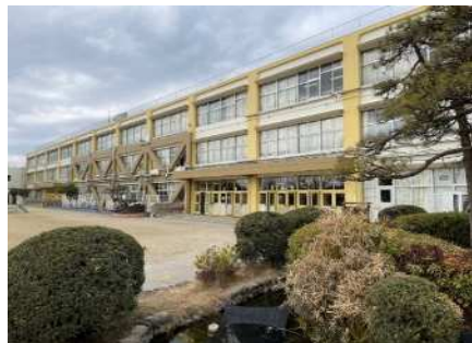
屋上防水等を実施した柏小学校
