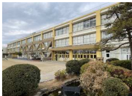
屋上防水等を実施した柏小学校
