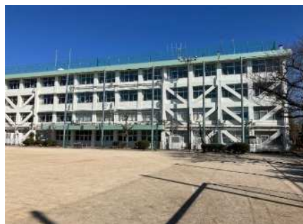
中規模改修した第九中学校
