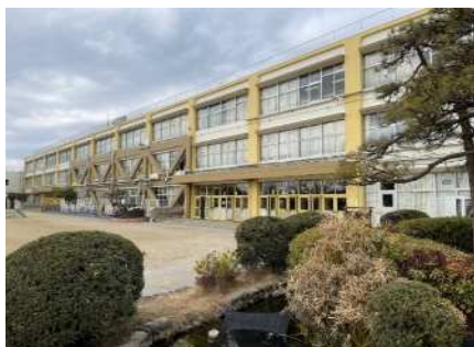
屋上防水等を実施した柏小学校
