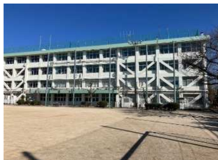
中規模改修した第九中学校
