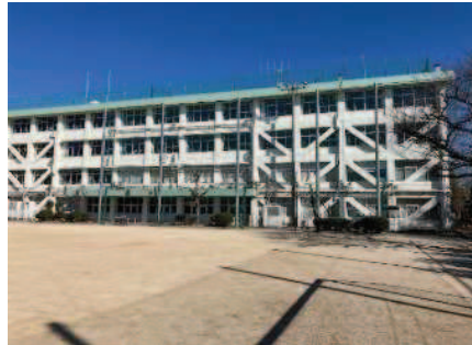
中規模改修した第九中学校
