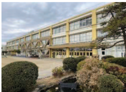
屋上防水等を実施した柏小学校
