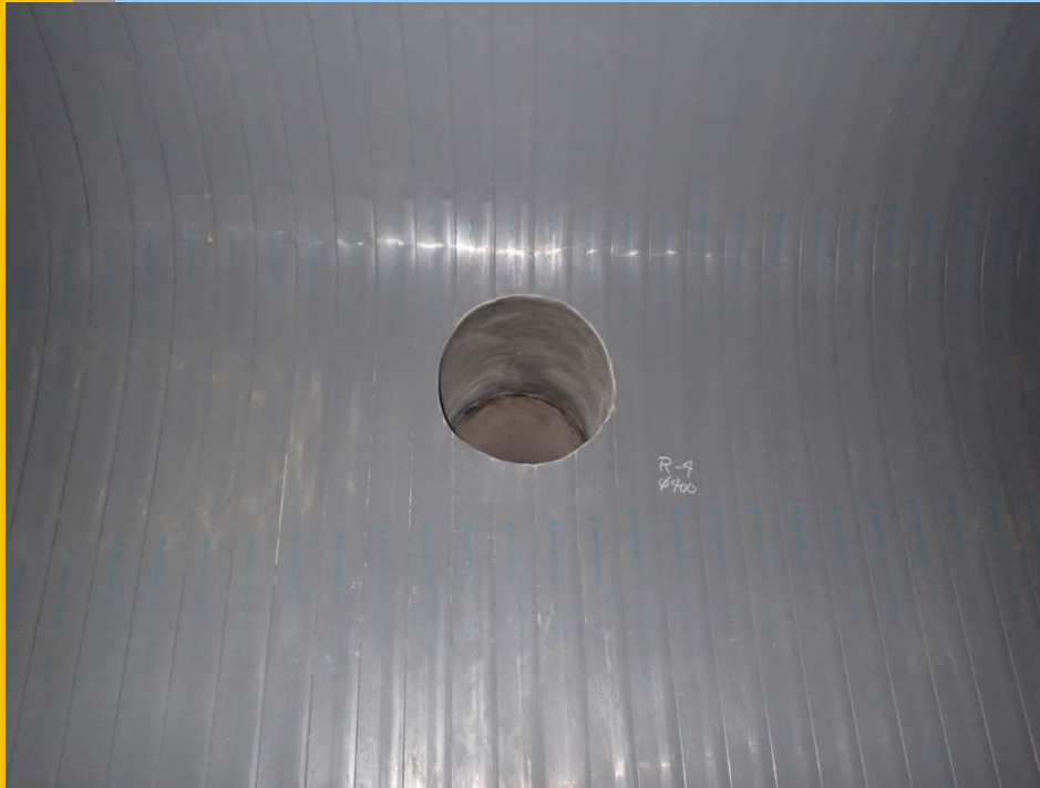
取付管口仕上げ後
