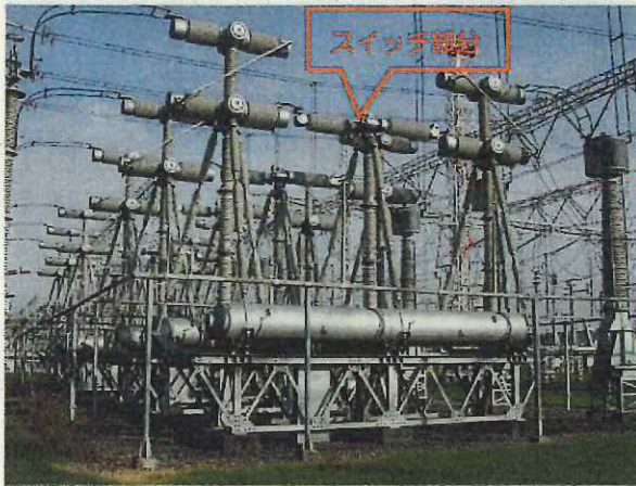
27万ボルト空気遮断器
