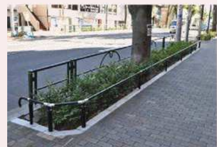
根上がり対策後の様子
