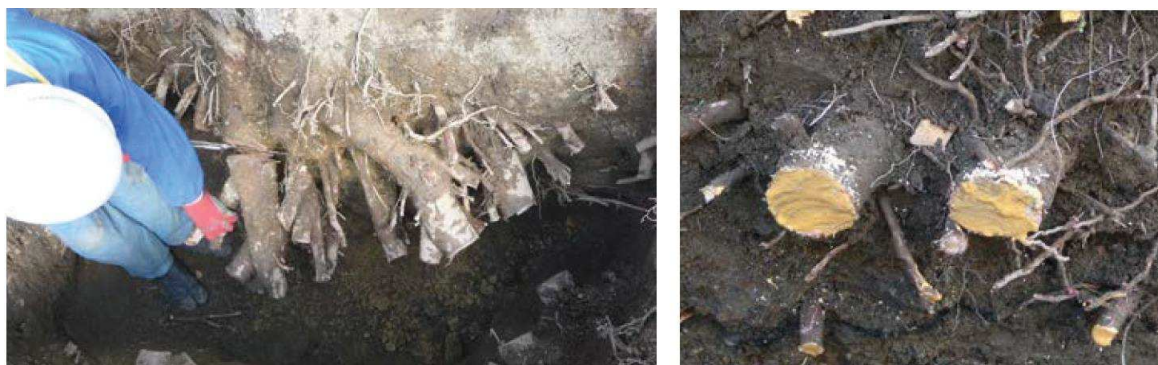
図 4-34: 根系切除と殺菌剤塗布の様子 (出典：街路樹再生の手引き/国土技術総合研究所)
