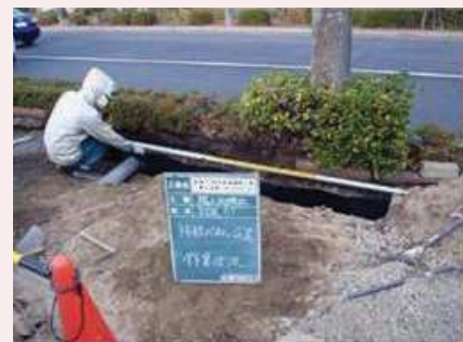
根上がり対策の施工中の様子
