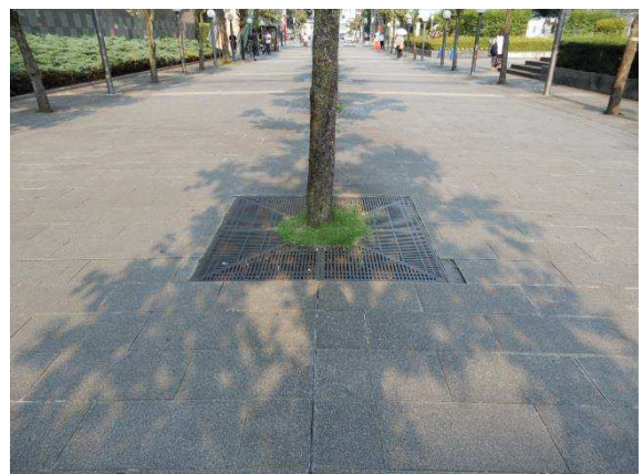
写真：踏圧防止盤による植樹柵
