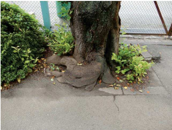
写真：狭小な植栽基盤
