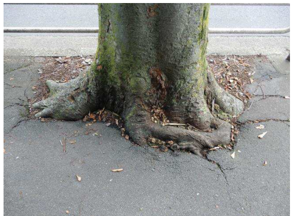
写真：根上りを生じたケヤキ (東 104 号線)
