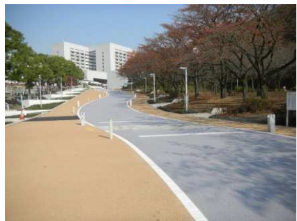
④カーアスファルト舗装
