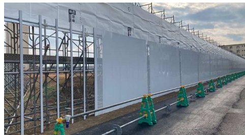
[仮囲いフラットパネル+防音シート]
