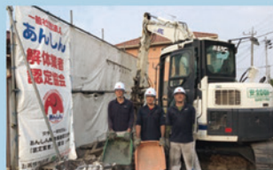
解体現場の視察
