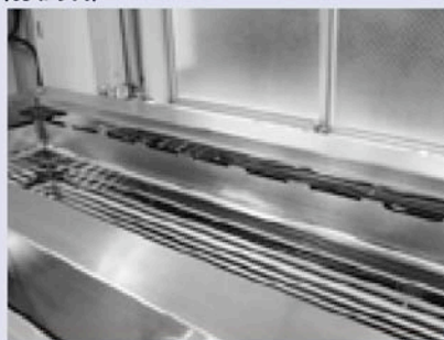
フリーボード比を上げるための冷却コイルのかさ上げ
