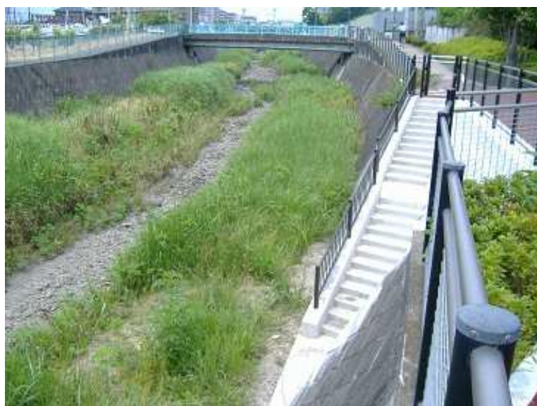
残堀川新残堀橋付近
