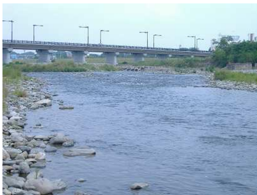
多摩川日野橋付近
