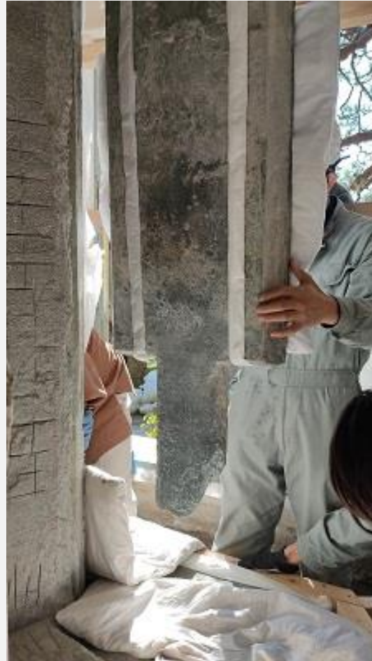
令和3年解体作業 内部・地中 コンクリート解体し、板石を 取外す。微振動工具の手作業
