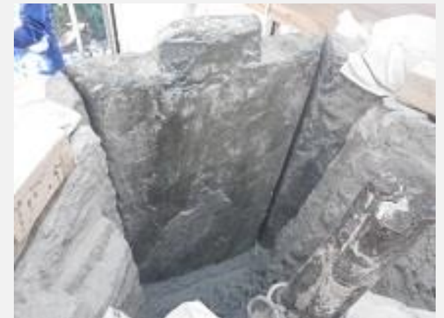
(内部コンクリートの除去作業)
