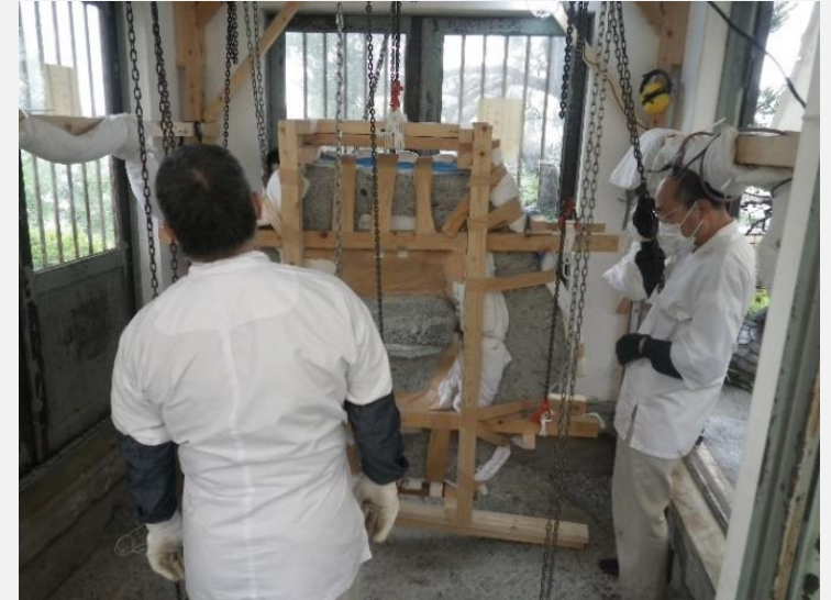
令和4年解体作業 (台石取外し)
