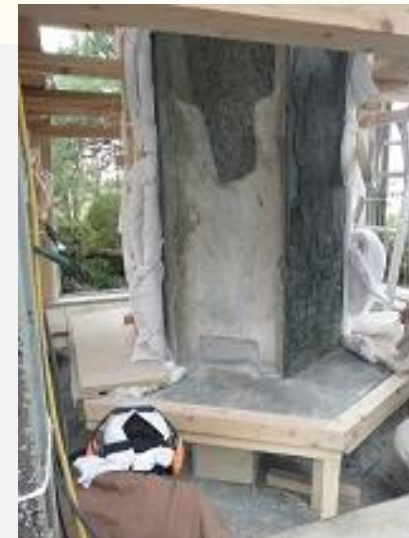
令和2年解体修理作業
