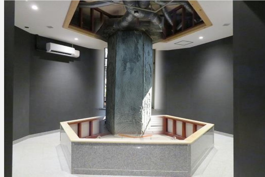
国宝新保存庫内 施工状況
