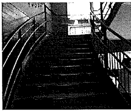
児童生徒の成長に配慮したユニバーサルデザインによる2段手すりを整備
