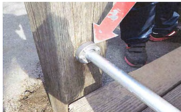
木材や金属の腐食の有無の点検
