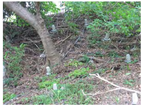
複数のアンカーボルトで斜面を固定し、崖線の樹木をできる限り残した安全対策の例（立川公園内）
