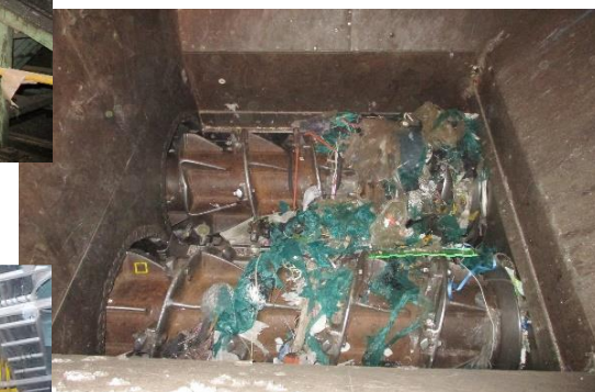
一次破碎設備内部（現在）
