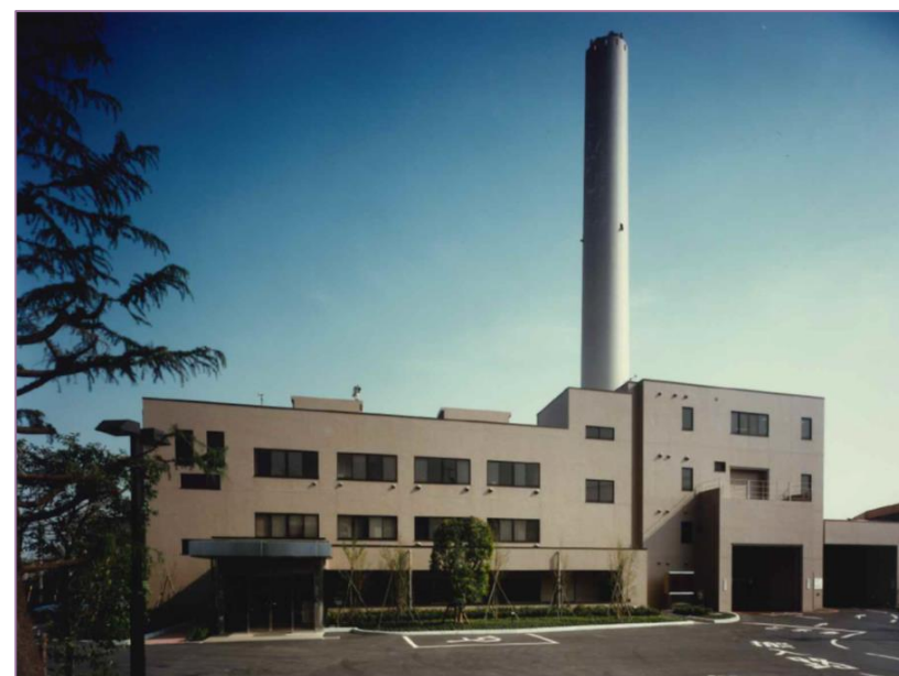
旧清掃工場の外観
