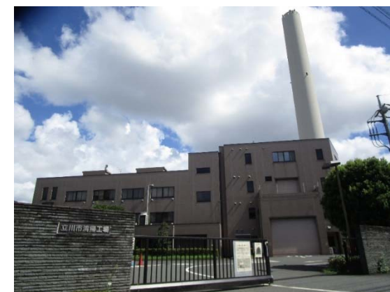
旧清掃工場の外観
