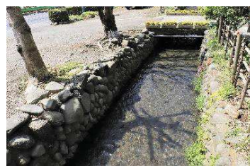
No54, 砂川分水の開渠遺構
