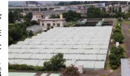
錦町下水処理場 一年中休みなく運転しています
