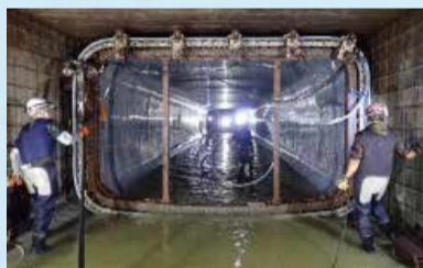
既設の下水道管の内側に作られた更生管
