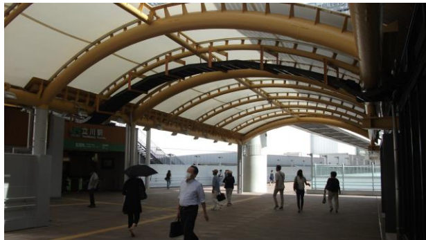
立川タクロス前広場方向より撮影
