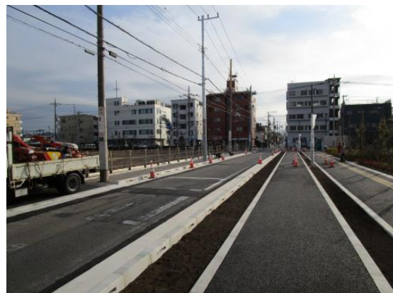
市道南375号線（整備中）
