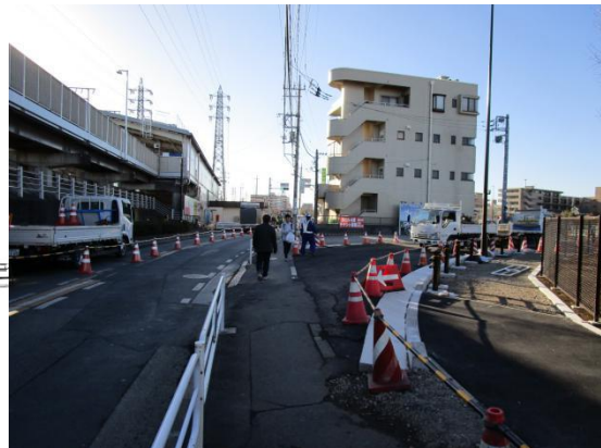
武蔵砂川駅前広場整備状況
