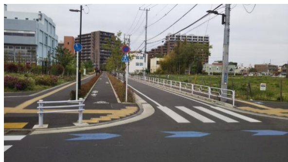
市道南375号線 整備状況
