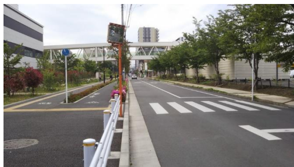
市道1級5号線（やすらぎ通り）整備状況
