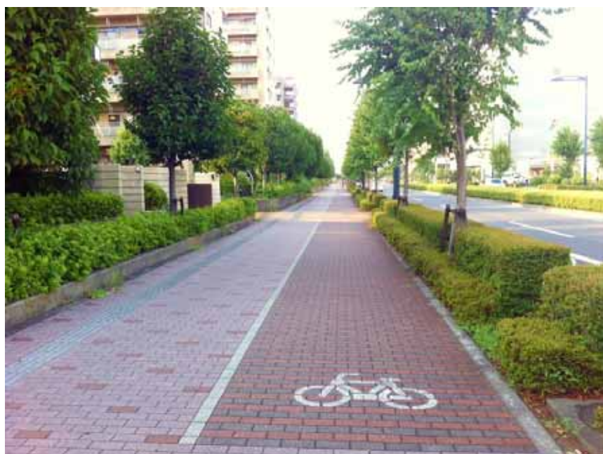
図 3-114 歩道・自転車走行空間が確保された道路 (立川市立川市道 1 級 19 号線(西大通り))
