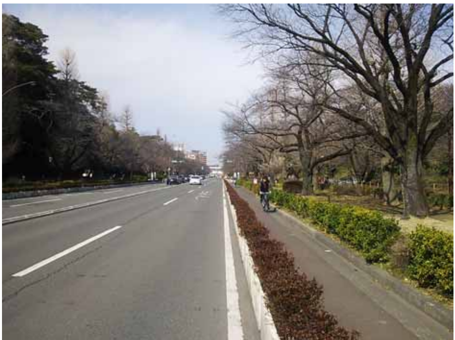
図 3-116 歩道・自転車道が確保された道路 (国立市 都道 146 号国立停車場谷保線(大学通り))
