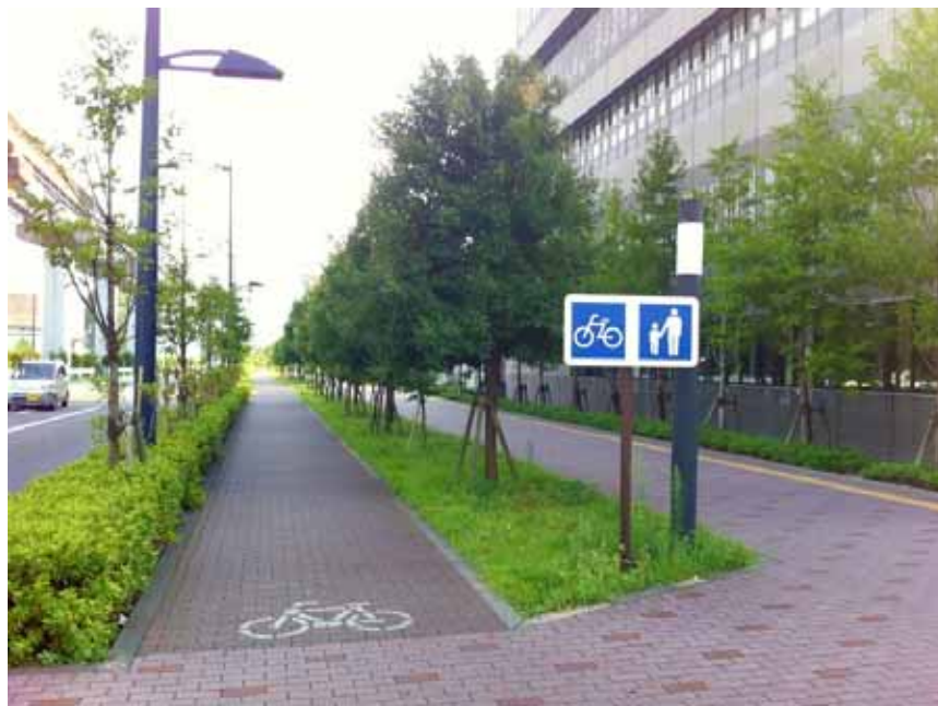
図 3-113 歩道・自転車走行空間が確保された道路 (立川市 主要地方道 43 号立川・東大和線(芋窪街道))
