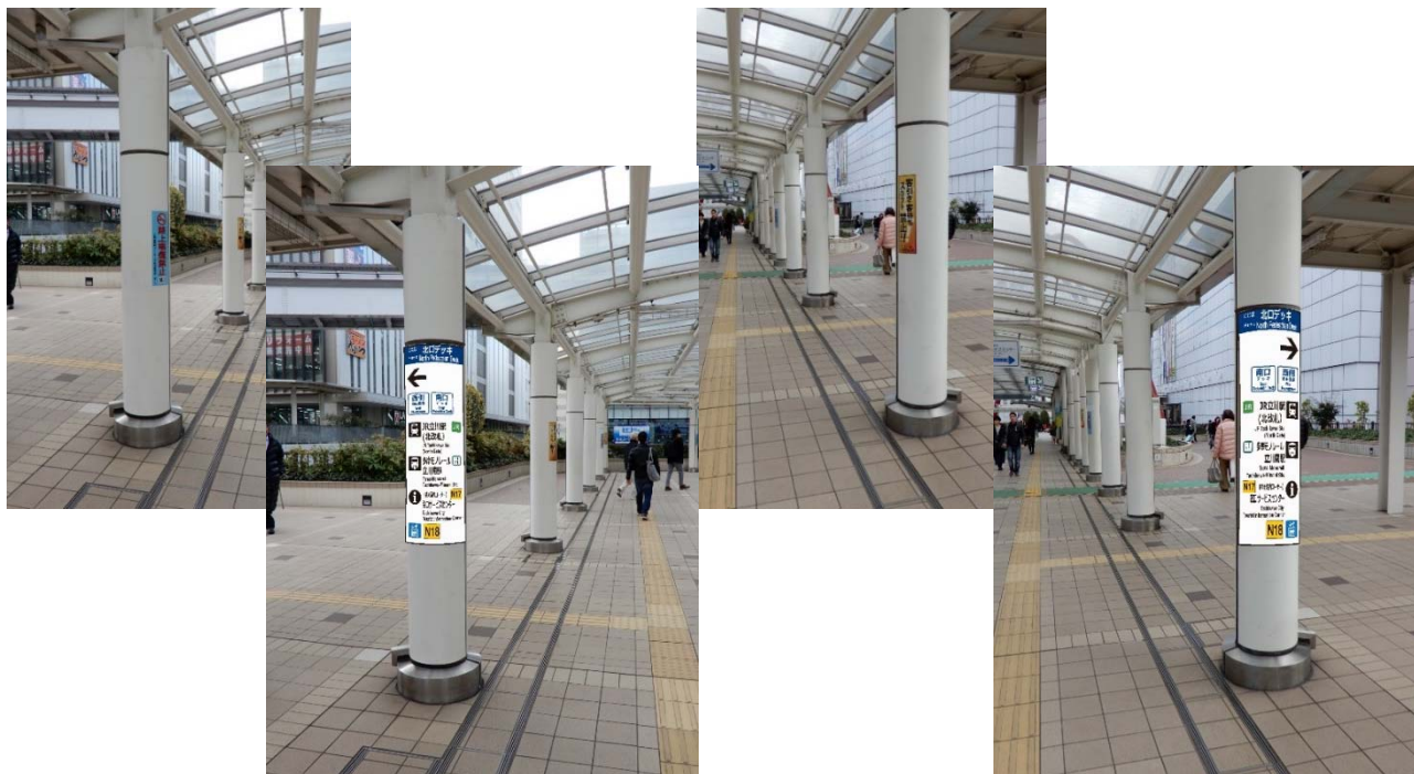
西側自由通路 03/R01年度 (左:現状 右:整備後)
