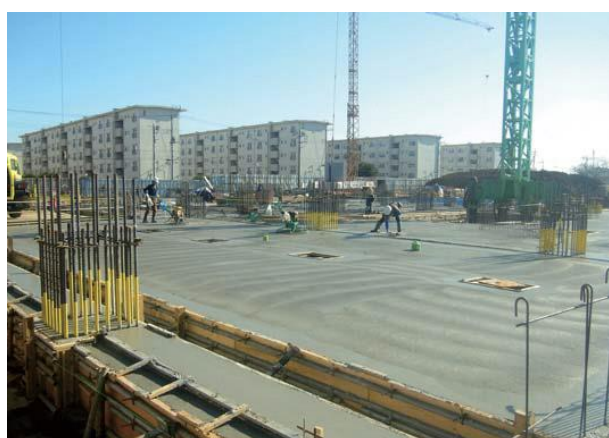
一階床工事（令和2年1月）
