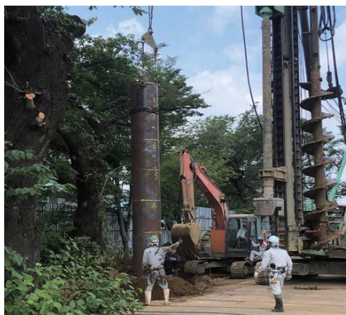
杭工事（令和元年8月）
