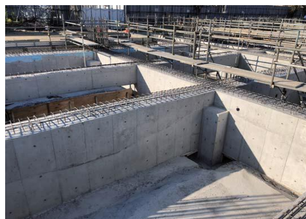
基礎工事②（令和元年11月）
