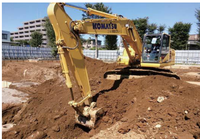
土工事（令和元年9月）
