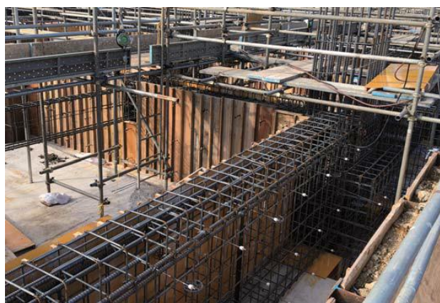
基礎工事①（令和元年10月）
