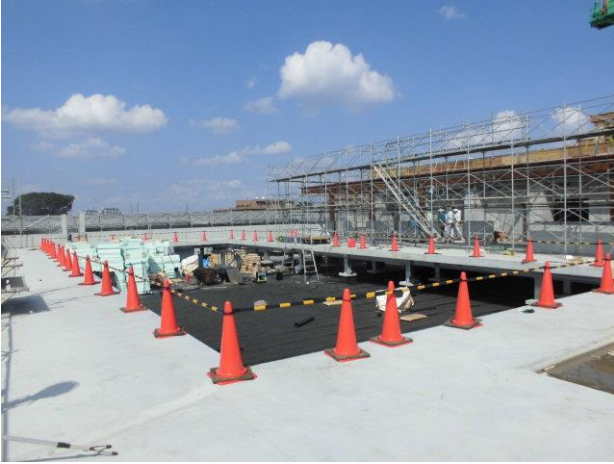
屋上プール工事（令和2年8月）
